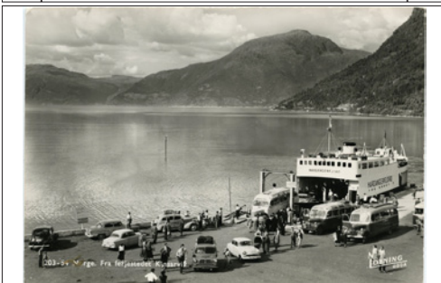
NR 128 Ho «Fra ferjestedet Kinsarvik» (med «Har- dangefjord») Løyning 203-54 ufr. kv1
