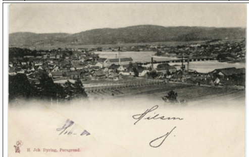
NR 320 Te (Porsgrunn oversikt) Alstrup. H. Joh. Dyring, kr. 75 Porsgrund. Fr. 1900 Kv.
