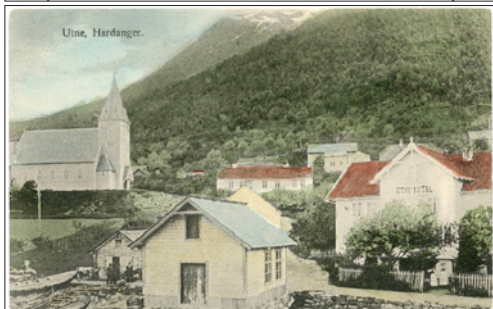
NR 39 Ho «Utne. Hardanger» Hulda Bentzen 1906. Brukt 1908 kv.1 kr. 75
