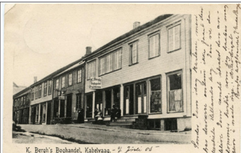
NR 150 NO K. Bergh's Boghandel, Kabelvaag, br 1905, kv 2-3 (liten hjørnebrekk)
