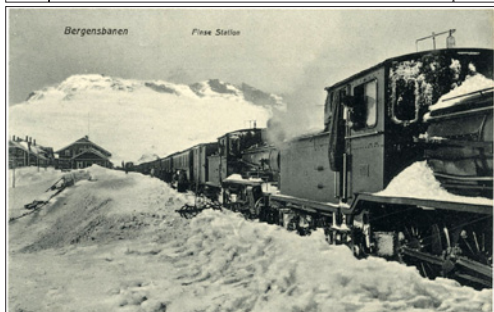
NR 336 HO Finse Station, Bergensbanen (m/lokomotiv), G.H.815, ubr, kv 1
