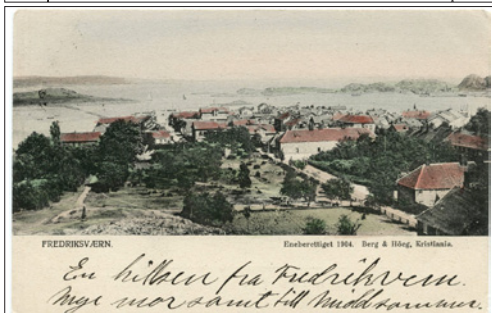
NR VF Fredriksvæn (Stavern), Berg & Høeg 384 1904, br, kv 2
