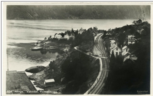
NR HO Vaksdal, Vossebanen, Mittet & Co 654, kr. 390 ubr, kva 1 75
