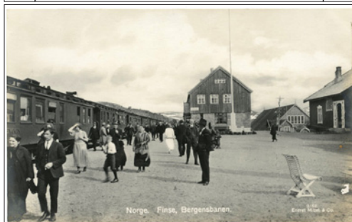
NR 335 HO Finse, Bergensbanen (m/tog). Mittet & Co 9/52, ubr, kv 2
