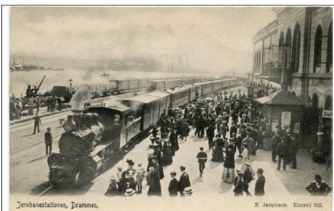
NR 506 BU Jernbanestasjonen m/tog, Drammen, E. Jacobsen 702, ubr, kv 1
