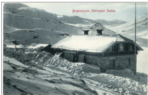
NR 337 HO Hallingskei Station, Bergensbanen N.K. 1425, ubr, kv 1-2 kr. 75
