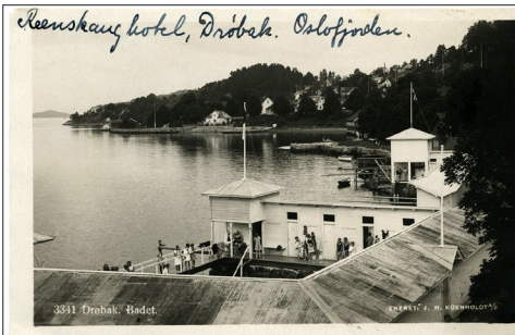
NR AK Drøbak Badet, Küenholdt 3341, stpl 492 Drøbak 1930, kv 3
