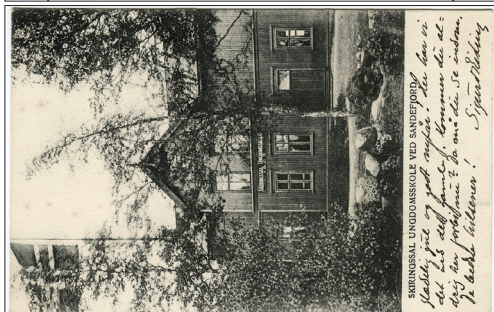
NR 71 VE Sikringssal Ungdomsskole ved Sandefjord, ukj utg, br 1904, kv 1-2 kr. 75
