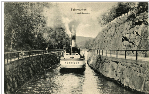
NR 534 TE Telemarken Løveidkanalen m/"Nordsjø", P. Alstrup 1446/1906, ubr, kv 1
