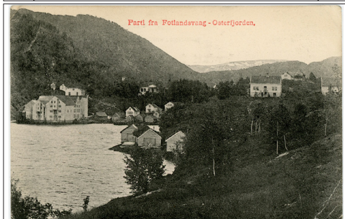
NR 351 HO Parti fra Fotlandsvaag - Osterfjorden, F.Beyer 1540, ubr, kv 3-4 (hj.brekk)
