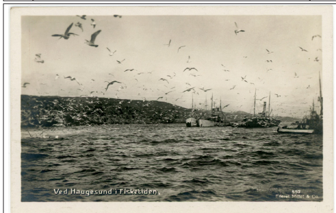
NR 335 RO Ved Haugesund i Fisketiden, Mittet 557, ubr, kv 1-2 kr. 75
