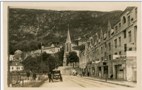
NR 334 HO Bergen Fra Nye Sandviksvei, Oppi Nr 356, ubr, kv 1 kr. 75
