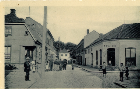
NR 379 ØF Fredrikstad Voldport Gaden, Carl A Larsen, ubr, kv 3 kr. 75
