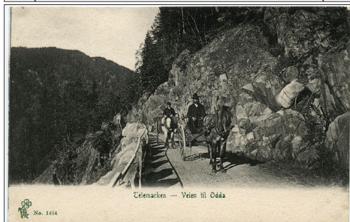
NR 143 TE Telemarken - Veien til Odda m/hestekjer-rer, P.Alstrup No 1454, udelt bakside, kv 2
