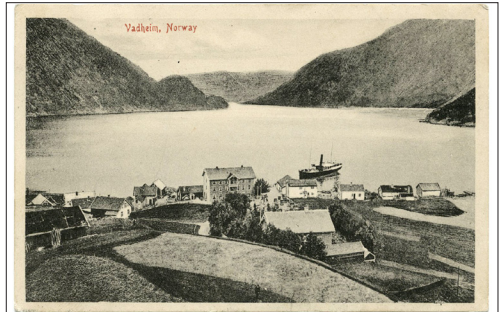
NR 292 SF Vadheim, O.Wichstad/N.L.R. No 540, stpl Sogns Posteksp. B, kv 2-3
