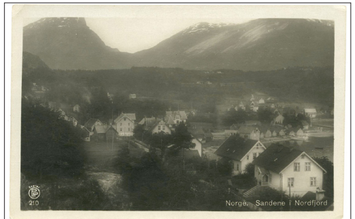
NR 294 SF Sandane i Nordfjord, Oppi 210, ubr, kv 2
