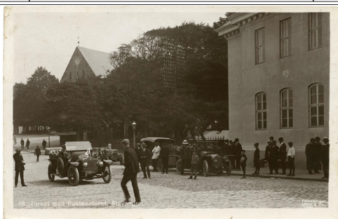
NR 48 RO Torvet med Postkontoret Stavanger, Mittet&Co 18, m/biler, br 1914, kv 2-3
