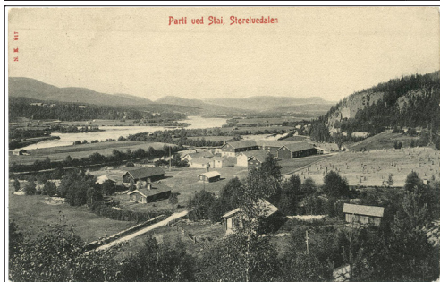
NR 27 HE Parti ved Stai, Storelvdalen, N.K. 917, stpl Koppang 1907, kv 2-3
