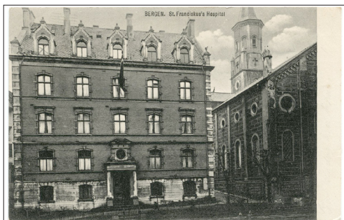
NR 209 | HO Bergen St.Fansiskus's Hospital, L.M.S. F:500 13, stpl Bergen 1916, kv 2-3 | kr. 75
