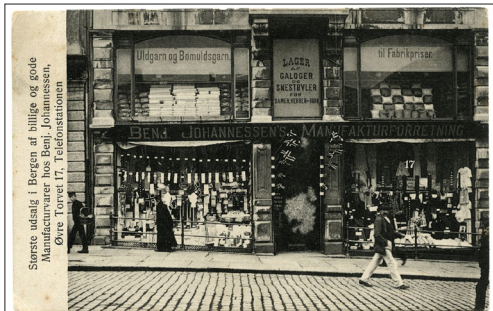
NR 181 HO Bergen Butikkforside Benj. Johannesens' kr. 100 181 Manufakturforretning, ca 1908, kv 2-3
