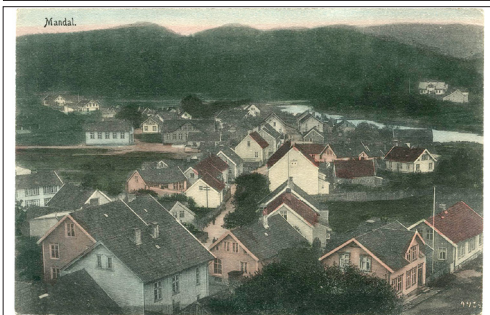
NR 156 VA Mandal Sentrumsbebyggelse, N.K Nr 228, ubr, kv 2 kr. 75
