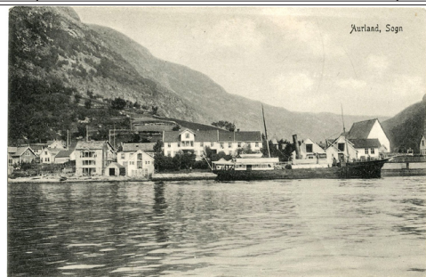
NR 272 SF Aurland i Sogn m/fjordabåt, A.B. no.57, kv 2 100
