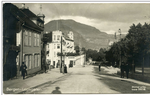
NR 325 HO Bergen Logegaten, Mittet&Co 3608, stpl Bergen 1917, kv 3 (svak Brett) kr. 75
