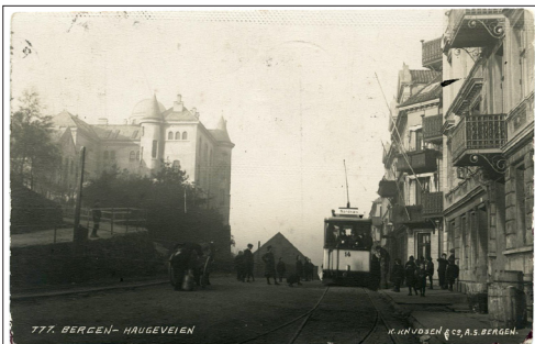
NR 362 HO Bergen Haugeveien m/Nordnæs-trikk nr 14, K.Knudsen 777, stpl Bergen 1915, kv 2-3 kr. 100
