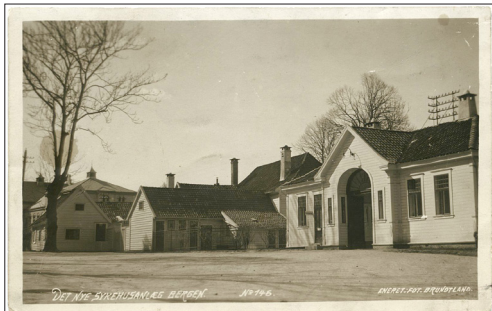
NR HO Bergen Det nye Sykehusanlæg, 469 Brundtland No 146, br, kv 2-3
