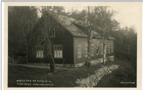
NR 488 HO Verkstad og Smidja, Framnes Ungdomsskule, T.Lofthus, br, kv 1-2 kr. 75
