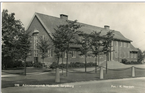
NR 500 | ØF Sarpsborg, Administrasjonsbygning 500 Havnslund, K.Nordahl 598, br, kv 2 | kr. 75
