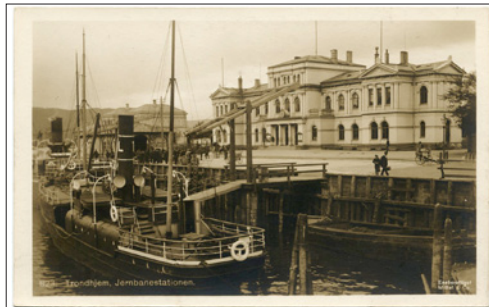
NR 341 | TRØ Trondheim Jernbanestasjonen, Mittet 823, ubr, kv 2 | kr. 75
