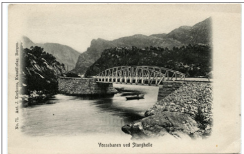
NR 51 HO Vossebanen ved Stanghelle, AJK 71, ubr kv 2-3
