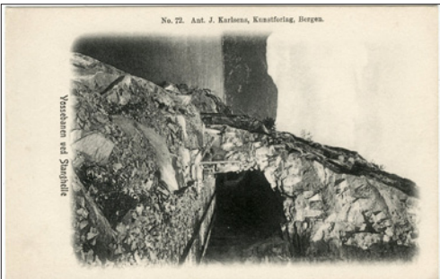
NR 52 HO Vossebanen ved Stanghelle, AJK 72, ubr kv 2
