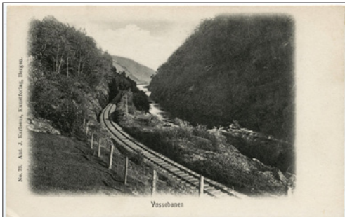
NR 53 HO Vossebanen, AJK 73, ubr, kv 2
