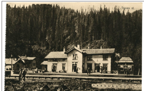
NR 373 TRØ Støren st., Mittet No 29, ubr., kv 1-2
