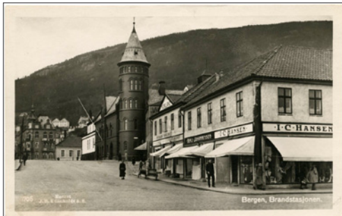
NR 277 HO Bergen Brandstasjonen, Küenholdt 1705, ubr, kv 2
