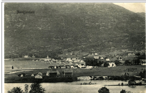
NR 91 SF Nordfjordeid, Brødrene Totlands bog-handling, ubr, kv 1-2 kr. 75
