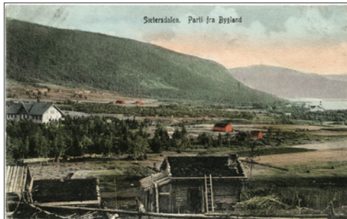
NR 445 AA Sæterdalen Parti fra Bygland, John Fredrikson 80, br 1908, kv 3
