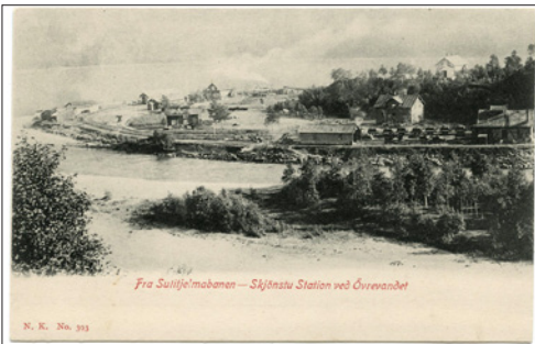
NR 388 NO Sulitjelmabanen Skjønstu station, N.K. 393, kv 2
