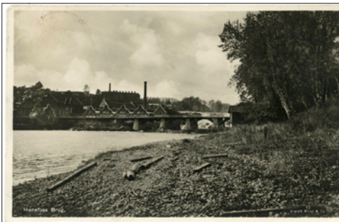
NR 444 BU Hønefoss Brug, Enerett Mittet & Co 52, br 46, kv 2-3
