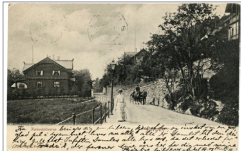
NR 1904, kv 3 HO Kalvedalsveien Bergen, O.Svanøe, br 261 kr. 75
