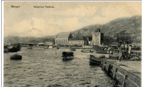
NR 534 | HO Bergen Bergenhus Fæstning, Paul E 1911, kv 1 | kr. 75
