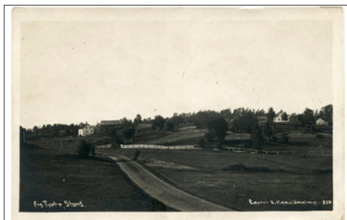
NR 217 HO Fra Tvede Stord, Kanelønning 558, ubr, kv 3
