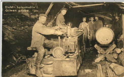
NR 391 NO Sulitjelma Elektr. lokomotiv i Giken gruve, uten utg., ubr, kv 2
