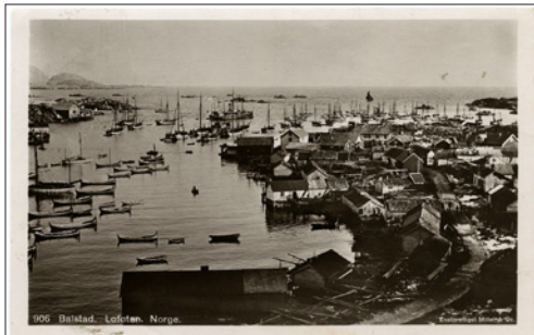
NR 429 NO Balstad Lofoten, Mittet & Co 906, br 1919, kv 2-3
