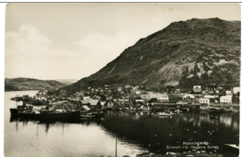
NR 116 FI Honningsvåg, G.Hagen, ubr, kv 2
