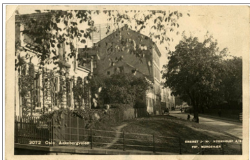
NR 546 OS Aakebergveien, Küenholdt 3072/Fot. Wardenær, br 1930, kv 3 (liten br) kr. 75
