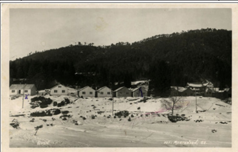
NR 80 HO Ulven Militærleir, Fot. Mortensen, br, kv 2
