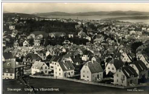
NR 515 RO Utsigt fra Vålandstårnet, Erling Søiland 21, ubr, kv 2 kr. 75
