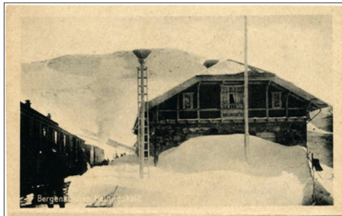
NR Jernbane Bergensbanen Hallingskeid, 157 E.Oppi Nr. 7, ubr, kv 2
