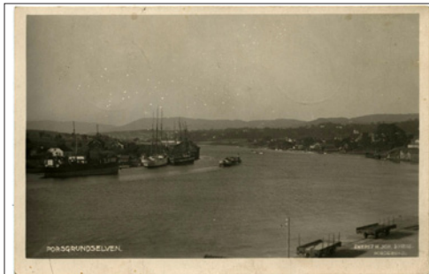
NR TE Porsgrundsølvnen, H Joh Dyring, br 349 1934, kv 2
