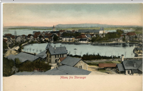
NR RO Stavanger Bredevandet, ubr, kv 1 352
