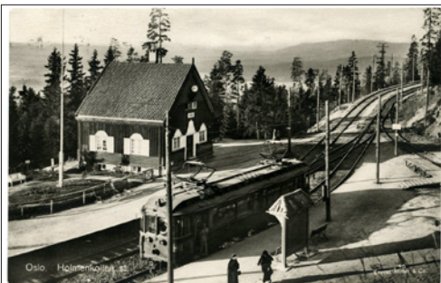
NR 170 OS Holmenkollen st, Eneret Mittet & Co 40, br 27, kv 1
