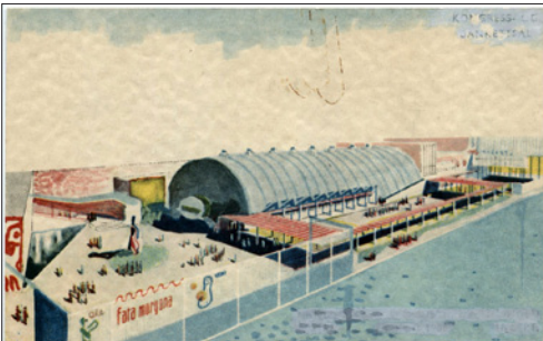
NR 336 OS Handwerks-und Industrie Ausst. Oslo 1938, deler av tittel sladdet over, ubr, kv 2-3
