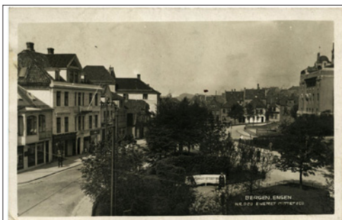
NR 41 HO Bergen Engen, Mittet & Co Nr 023, br 1922, kv 2
