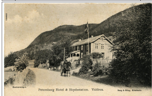
NR 407 OP Petersborg Hotel & Skydsstation Valdres, Berg & Höeg 109662, ubr, kv 1-2 kr. 75
