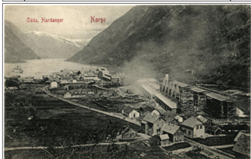
NR 232 HO Odda fabrikkken bygges, Mittet & Co 660, ubr, kv 1 kr. 75
