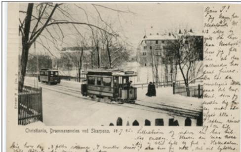
NR 212 OS Drammensveien ved Skarpsno, Eneret N J Uds 5, br 05, kv 1 kr. 100
