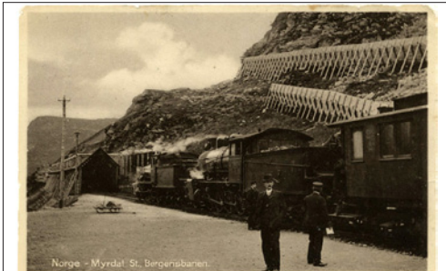
NR 92 Tema jernbane Myrdal St. Bergensbanen m/tog, J.H.Küenholt No. 52, ubr, kv 2 kr. 100
