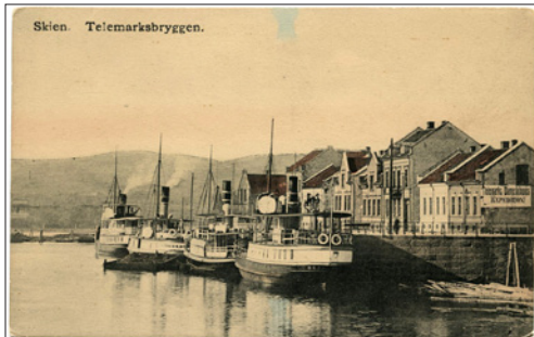
NR TE Skien Telemarksbryggen m/4 kanalbå- 365 ter, 7313,ubr, kv 1
