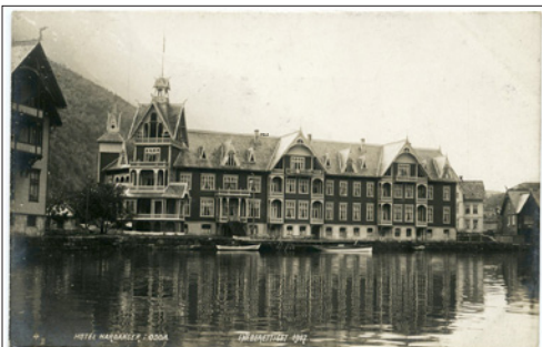
NR 553 HO Hotel Hardanger i Odda, ubr, kv 1
