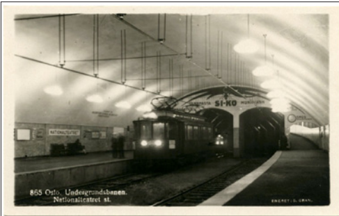
NR 172 OS Undergrundsbanen Nationalteatret st, S Gran 865, ubr, kv 1
