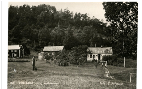
NR HO Eikeflaten Bru i Hardanger, S. Helge- 151 vold 165, ubr, kv 1-2
