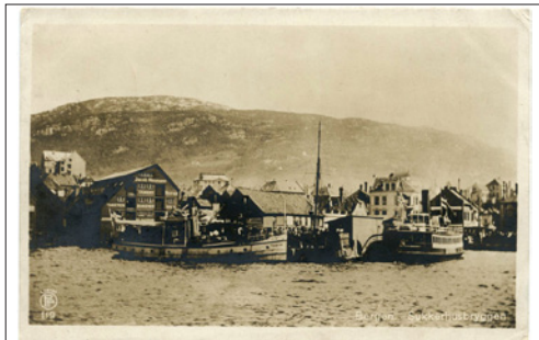
NR 325 HO Bergen Sukkerhusbryggen, Oppi 119, pent stpl Bergensbanens Postexp K -20, kv 1 kr. 100
