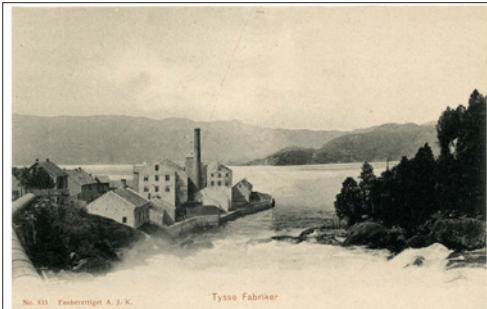
NR HO Tysse Fabrikk, A J K 833, ubr, kv 1 kv 2 kr. 100
