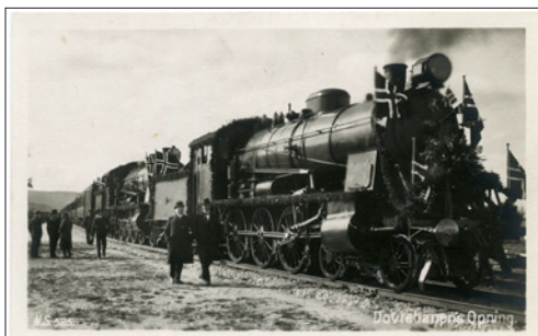
NR 297 OP Dovrebanens Opning, N S 525, ubr, kv 1 kr. 100
