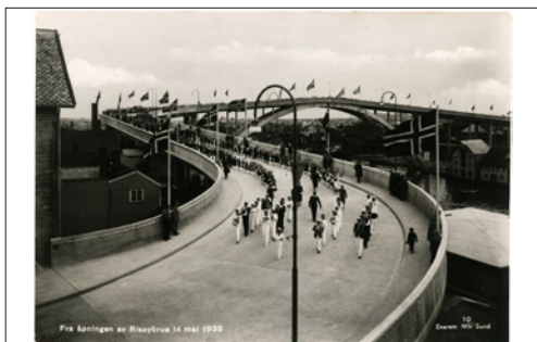
NR 113 RO Fra åpningen av Risøybrua 14 mai 1939, Nils Sund 10, ubr, kv 2 kr. 60
