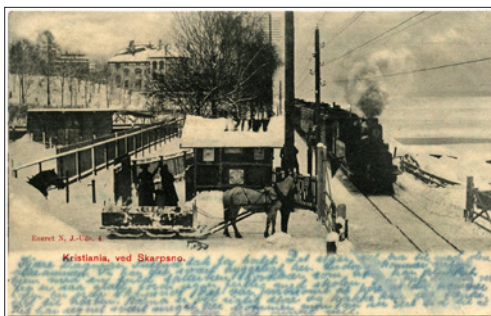
NR OS Kristiania ved Skarpsno, N.J.-Uds. 4, 218 br 07, kv 3 grunnet fuktskade
