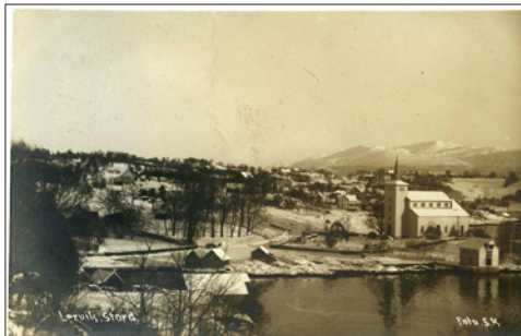
NR HO Leirvik Stord, Kannelønning, ubr, kv 3 246 (pga vertikal brett)
