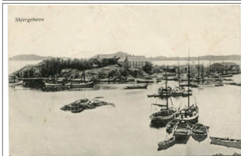
NR SF Skjergehavn, Eneret Mathiesen, ubr, kv 2-3 | kr. 435 grunnet småknekk | 60
