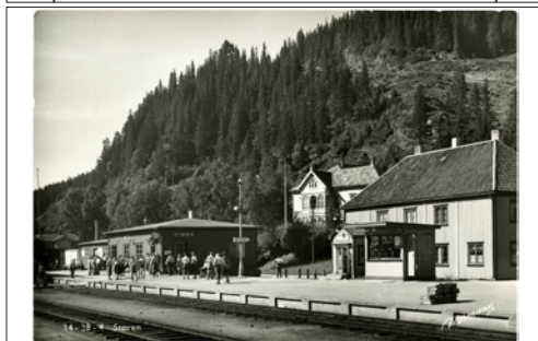
NR 479 TRØ Støren stasjon, Normann 14-38-4, ubr, kv 2
