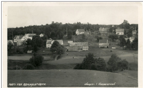
NR HO Rommelstveit, I.Ingebrigtsen, pent stpl Rommetveit -42, kv 1-2
