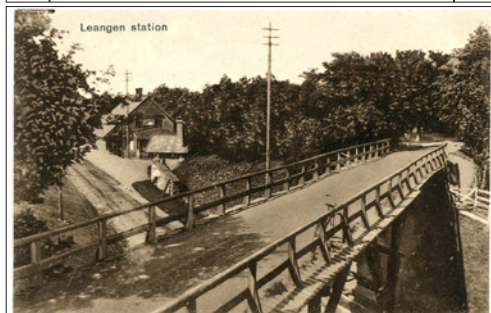
NR 535 Tema Jernbane Leangen station, A.Holbæk Eriksen, ubr, kv 1
