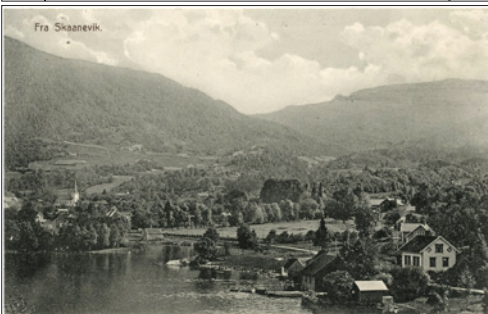
NR 224 HO Fra Skaanevik, Kannelønning 1910, pent stpl Skaanevik -11, kv 1
