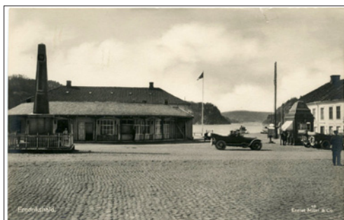
NR 490 ØF Fredrikshald, Mittet & Co 10, ubr, kv 1
