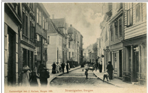
NR 192 HO Bergen Strandgaden, AJK 1512, ubr, kv 1-2
