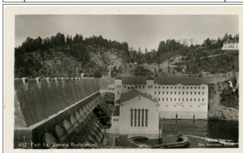
NR 495 ØF Vamma Kraftstation, Eneret 1920 Carl Normann 482, ubr, kv 1
