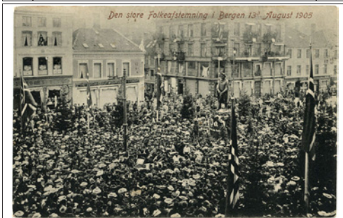
NR 160 HO Bergen Den store Folkeafstemning 13 august 1905, O Svanøe, br -06, kv 2
