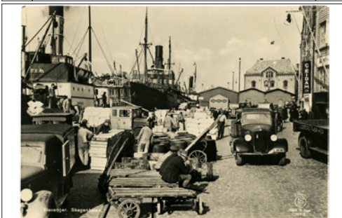
NR 416 RO Stavanger Skagenkaien, Oppi 167-S, ubr, kv 2 (små limrester bak i hj)
