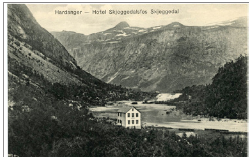
NR 237 HO Hotell Skjeggedalsfos, G.H. 853, ubr, kv 1-2
