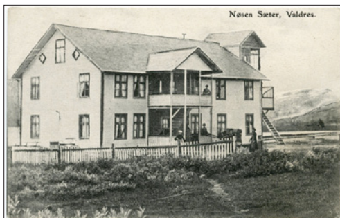
NR 378 OP Nøsen Sæter Valdres, Aune 82, ubr, kv 2 grunnet flekk på baksiden kr. 75
