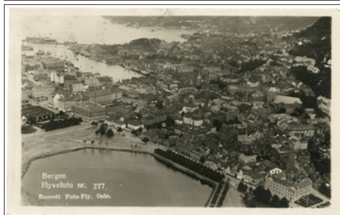
NR 387 | HO Bergen Sentrum Flyvefoto nr 277, Foto-fly Oslo, brukt frimerket fint fjerna, kv 2-3
