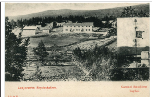
NR OP Lesjeværks Skydsstation, G B no. 60, 190 ubr, kv 1
