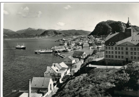
NR 458 MR Ålesund Havna Aspøy skole, Mittet 359, ubr, kv 1
