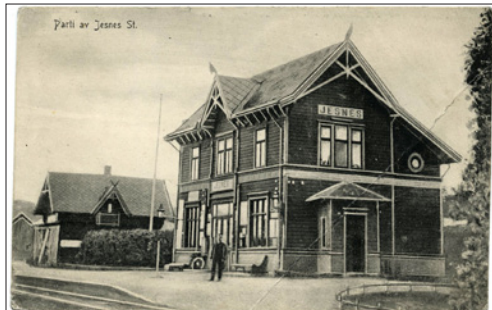
NR Tema Jernbane Parti av Jesnes St., NLR 557 615, brukt, kv 3 (brett) kr. 75
