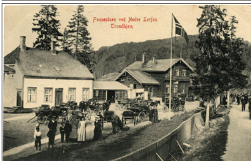
NR 484 TRØ Fossestuen ved Nedre Lefos, C A Erichsen Trondhjem 8, br 13, kv 1
