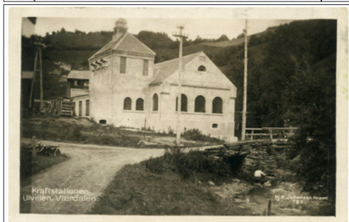
NR 487 TRØ Kraftstationen Ulvillen Værdalen, Hj.R. Johansen 782, ubr, kv 1
