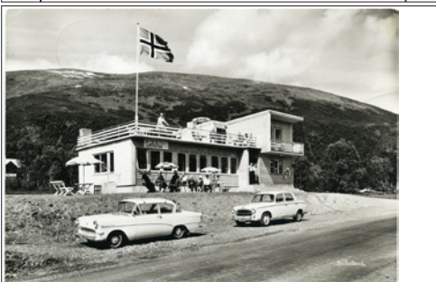
NR 464 MR Molde Fjellstua Skaset, Birkelund, stpl. Aukra -63, kv 2
